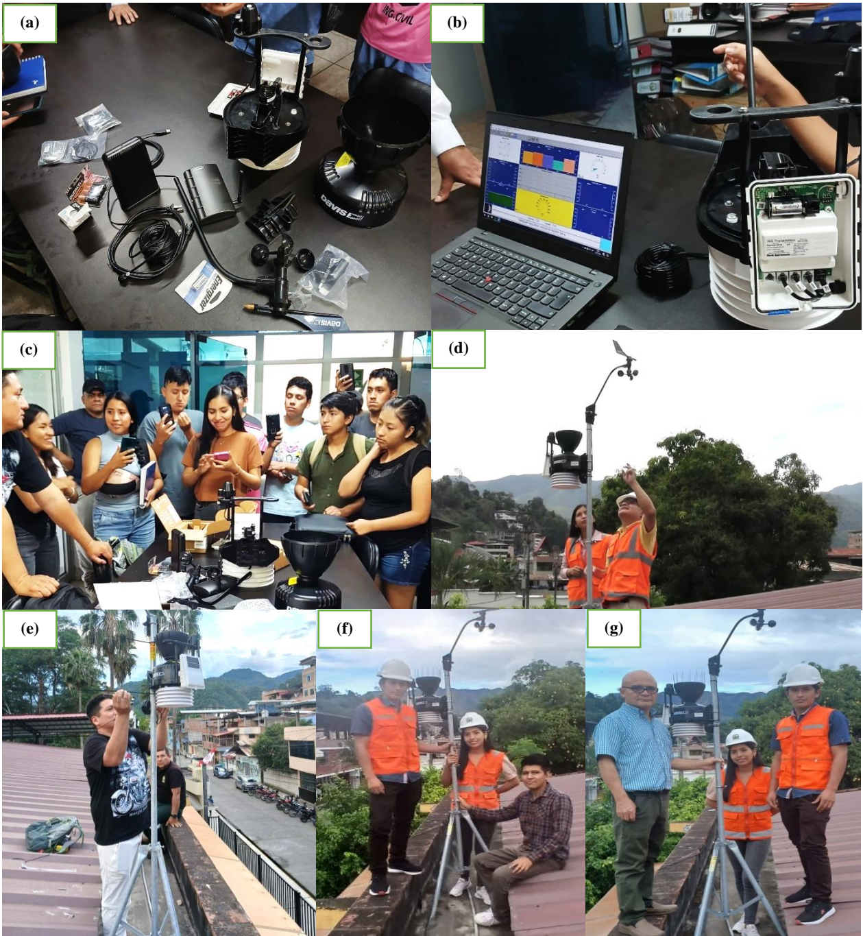
Nota. (a, b y c) Partes e instalación del software de la estación meteorológica, (d y e) Instalación de la estación meteorológica, (f y g) Mantenimiento y limpieza de la estación móvil.
