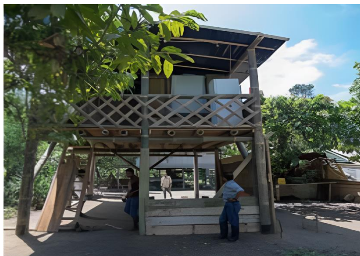
Figura 8 Casa de interés social construida tras el sismo ocurrido en Ecuador en 2016
