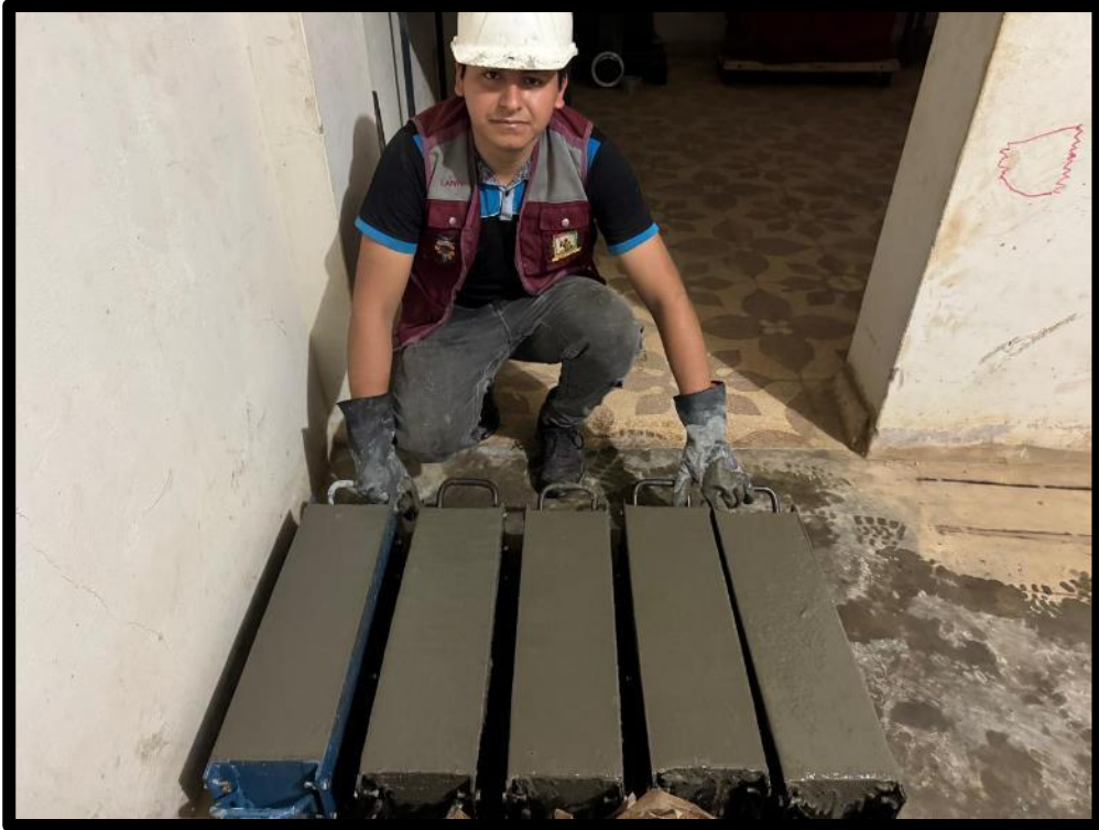
Foto 11: Realización de las viguetas de concreto.
