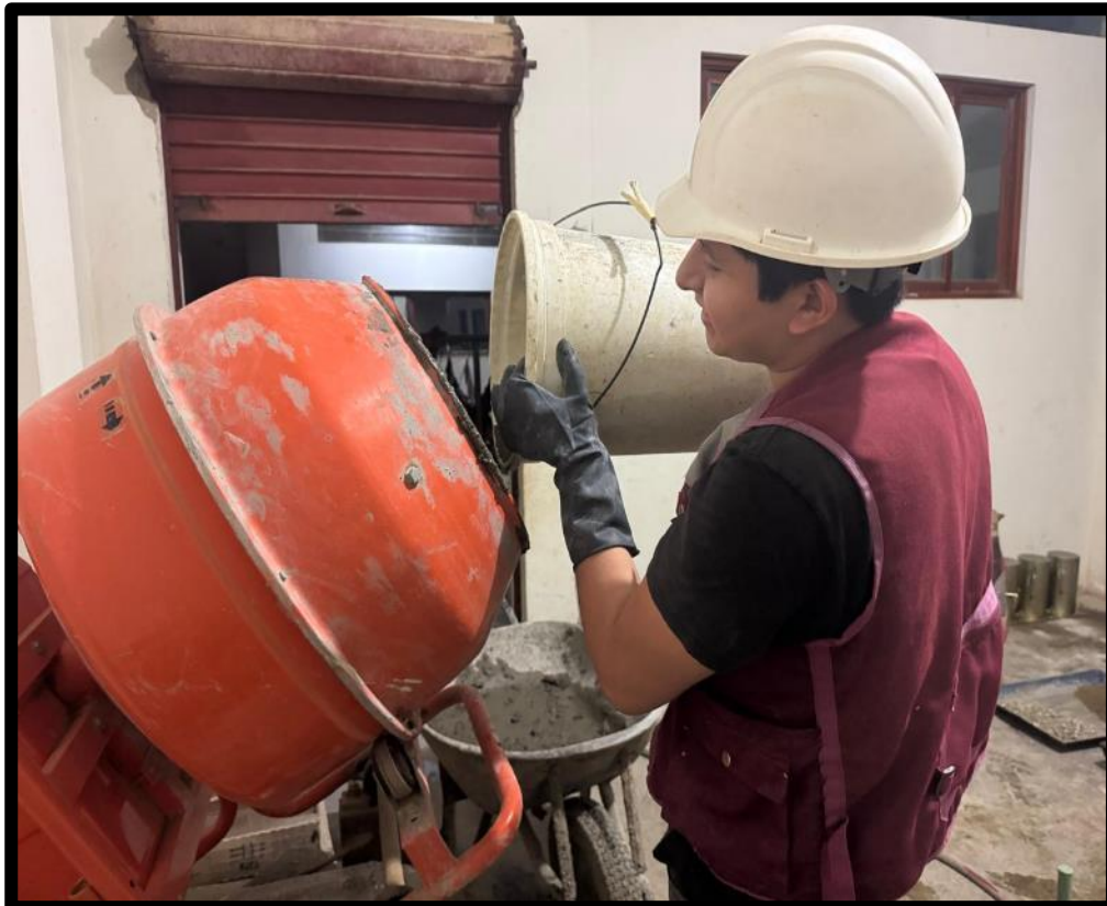
Foto 8: Mesclado de agregados en la mezcladora de concreto.
