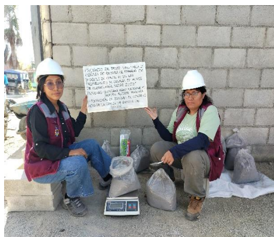
FOTO N° 17: Elaboración de los bloques de concreto
