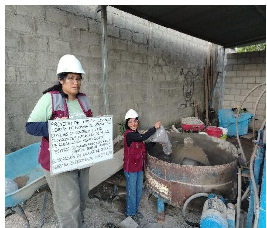
FOTO N° 18: Elaboración de los bloques de concreto
